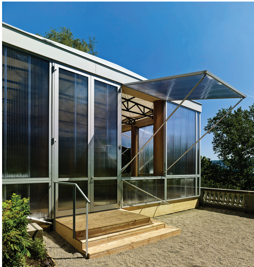
Die Polycarbonatfenster lassen sich mit Aluminiumstangen bis 90 Grad herausklappen. Realisiert hat sie die Firma Moderne Metallbearbeitung GmbH Grosswangen.
