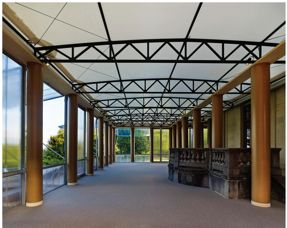
Zwölf der 24 Kartonröhren ruhen auf permanenten Stahlbetonfundamenten mit Mikropfählen, die bis 4 Meter in die aufgeschüttete Terrasse der Villa Wesendonck reichen. Die Carbon-Fachwerkhauptträger wiegen je nur 25 Kilogramm. Genutzt wird der Pavillon im Sommer als Erweiterung des Museumscafés.
