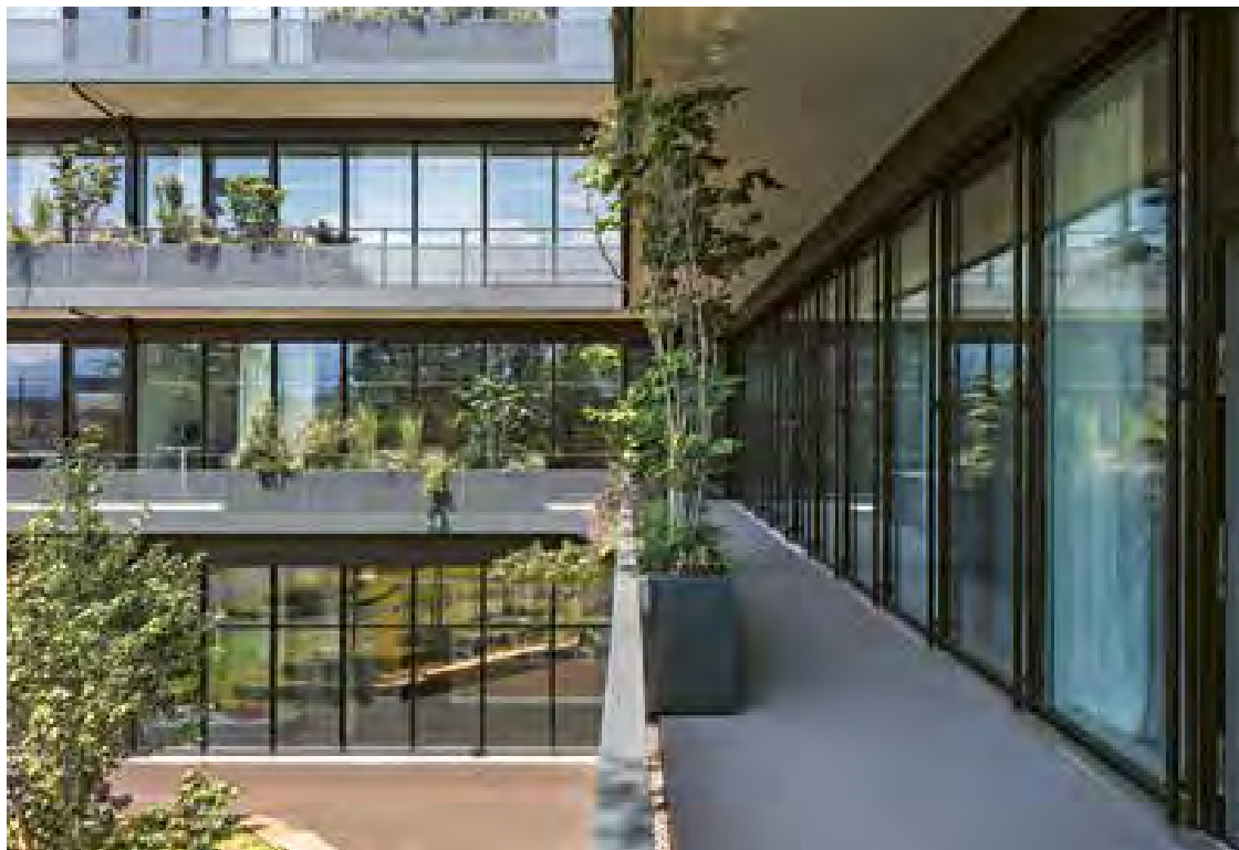
Das Architekturbüro Rüssli setzt bei Oppac in Rothenburg auf klassische Fassadenbegrünung. Die Pflanzen wachsen in grossen Trögen und sind direkt in die Fassade integriert. (Foto: Leonardo Finotti)
