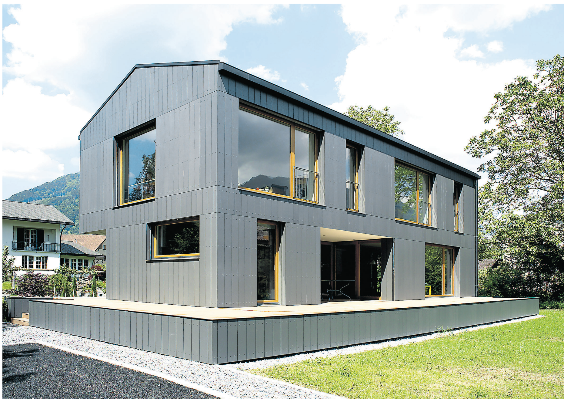
Südseite des Hauses im Glarner Industriedorf: Einfache Form in auffälliger Hülle
