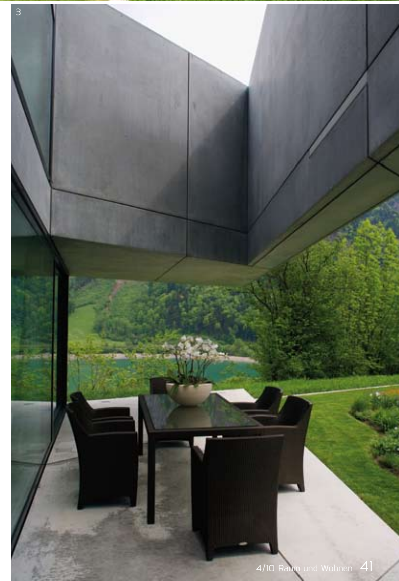
1 _Das Haus öffnet sich an seiner Südostecke als spitzer Keil mit eingefügter Terrasse und Dachdurchbruch. 2 _Eine zurückversetzte und über Eck geführte Fensterfront bietet Aussicht und Austritt ins Freie. 3 _Der geöffnete Dachraum über der Terrasse ist ein architektonisches Erlebnis.
